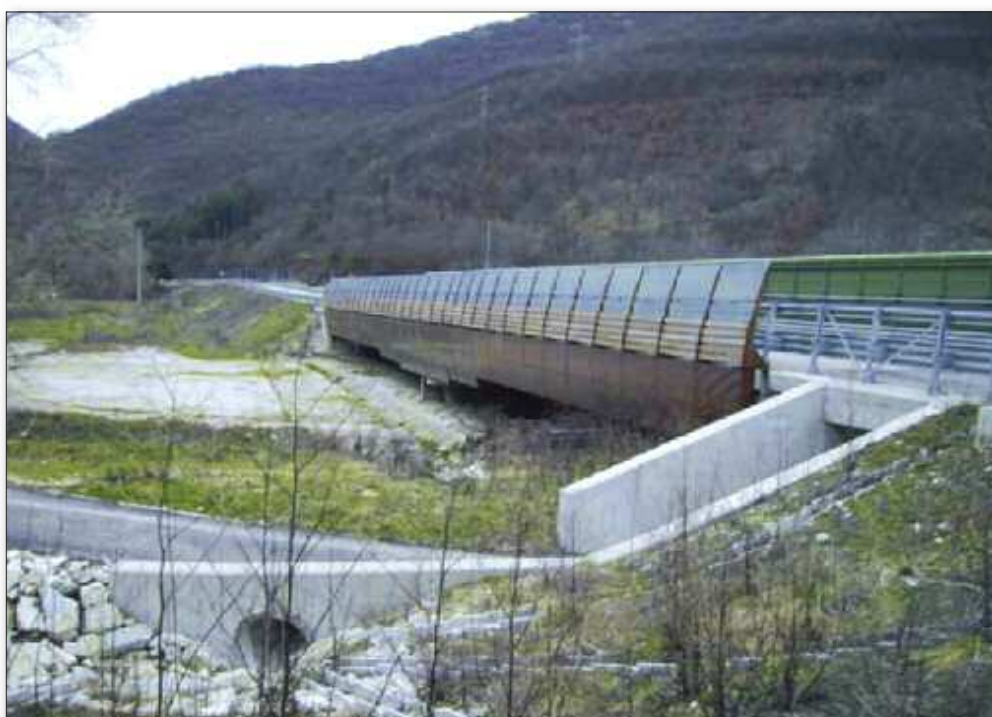
Fig. 23 - Viadotto Bavareto, particolare delle schermature, SS77
