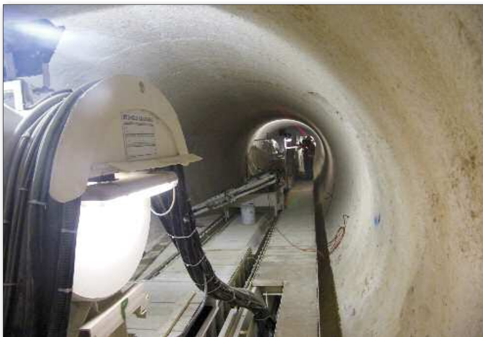
Fig. 6 - Scavo cunicolo di servizio galleria Gola della Rossa (AN), SS76
