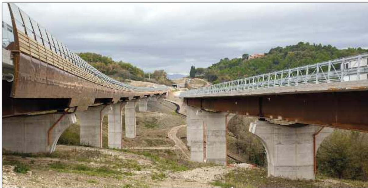
Fig. 28 - Viadotto San Lorenzo I a Foligno, SS77
