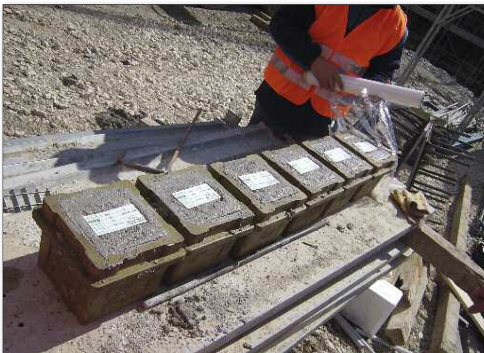
Fig. 13 - Attività in cantiere. Prelievi campioni in calcestruzzo
