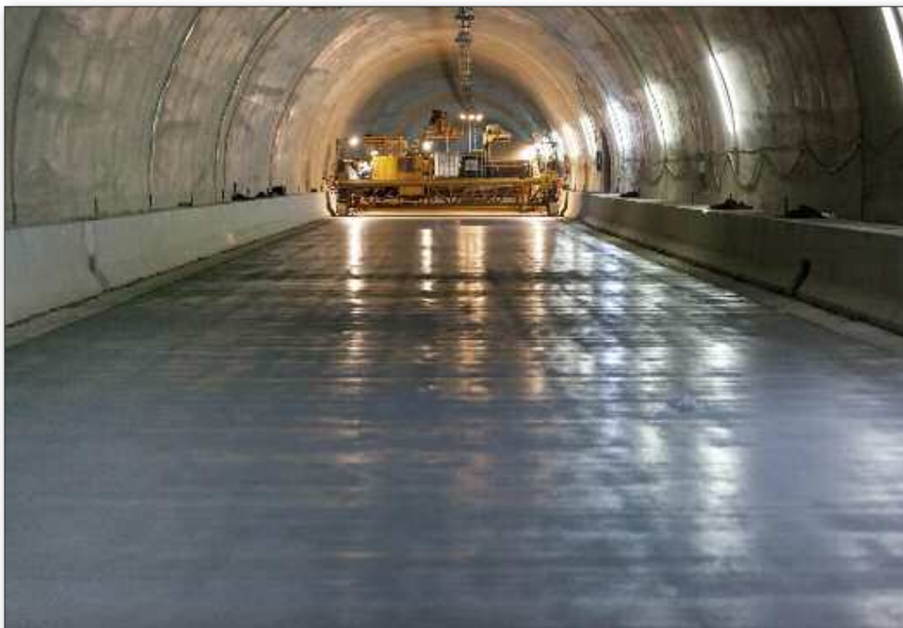
Fig. 5 - Pavimentazione in calcestruzzo nella galleria Belfiore (Foligno), SS77
