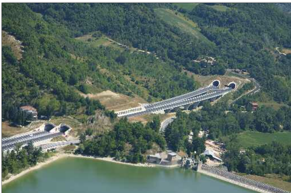
Fig. 15 - Strada statale 77, tratto Collesentino - Pontelatrave (MC)
