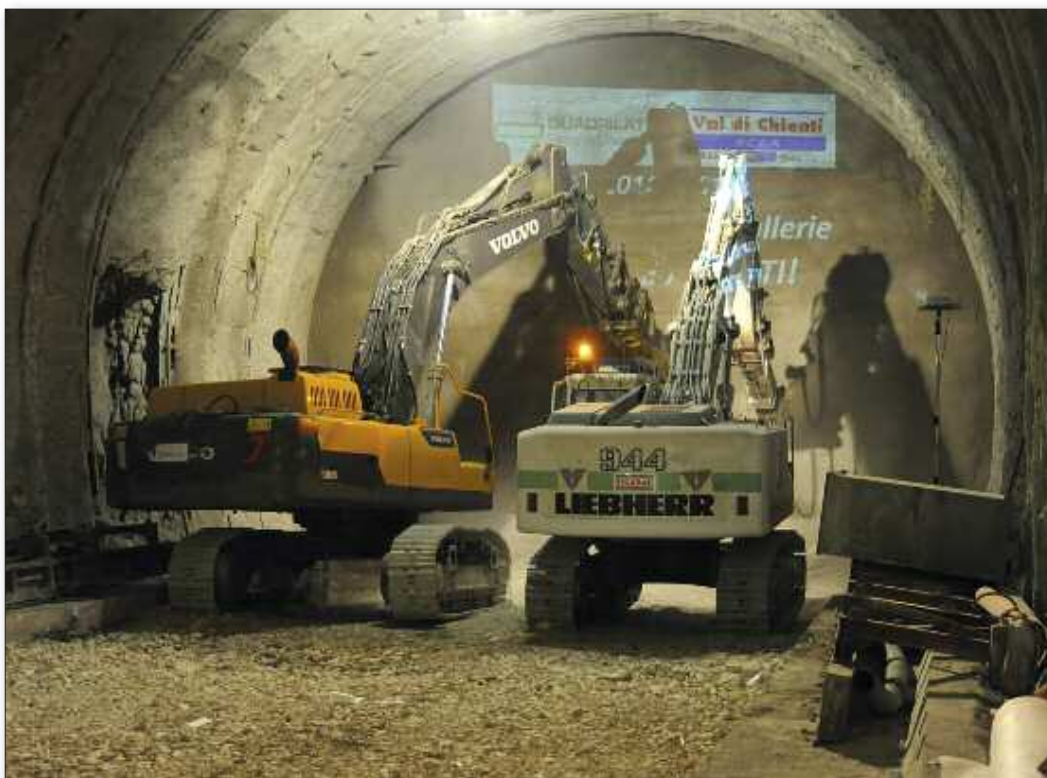
Fig. 14 - Abbattimento diaframma galleria Pale (Foligno) SS77, 4 dicembre 2013. Concluso lo scavo di tutte le gallerie
