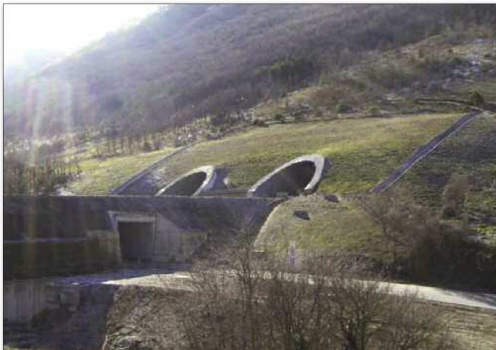
Fig. 25 - Galleria Varano, imbocco lato Pontelatrate (MC) SS77
