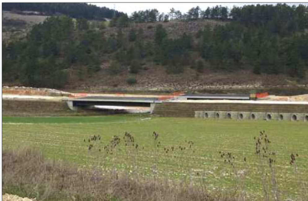
Fig. 22 - Ponte Rio Cesi nella Piana di Colfiorito (Foligno) SS77
