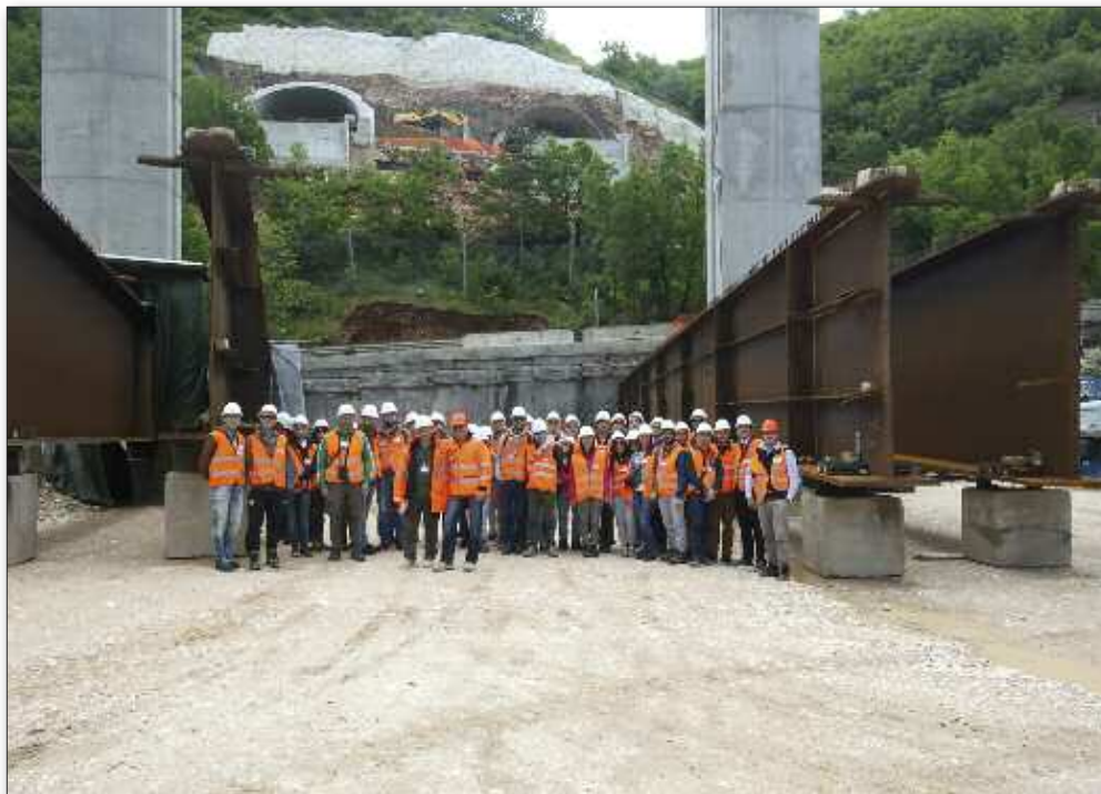
Fig. 24 - Studenti di Ingegneria dell'Università di Perugia nei cantieri SS77
