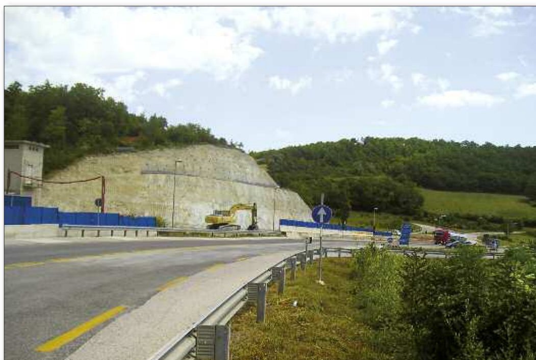
Fig. 10 - Lavori svincolo di Cancelli a Fabriano (AN), SS76
