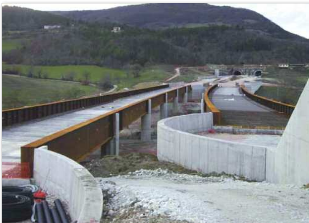
Fig. 18 - Viadotto Muccia, particolare delle spalle, SS77
