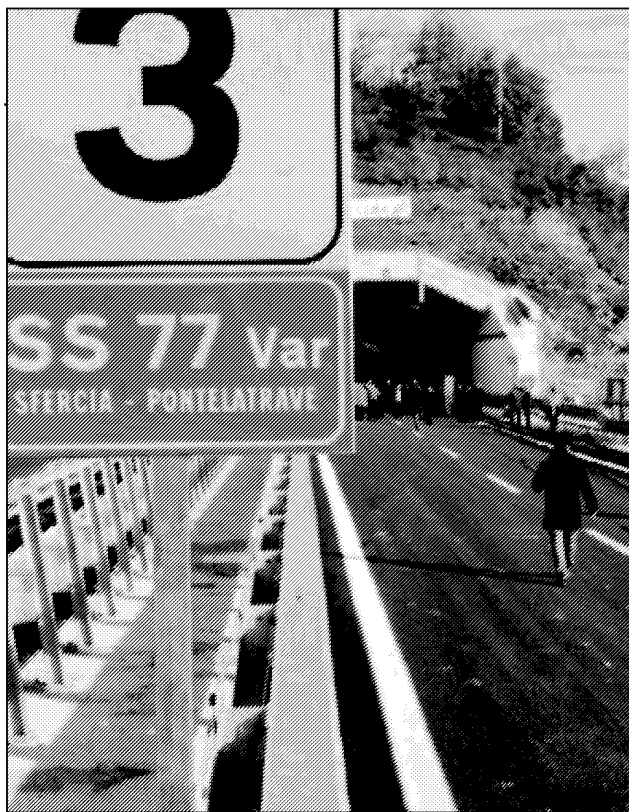
Sullo sfondo una delle gallerie del nuovo tratto della superstrada Valdichienti inaugurato ieri (foto Pierpaolo CALAVITA)
